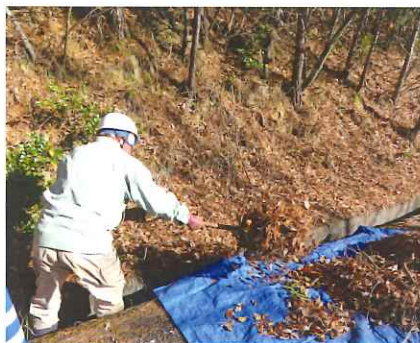
側溝清掃作業
